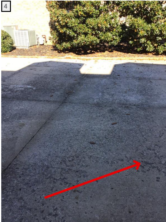
Spalling
